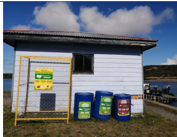
Figura 12. Instalación de punto verde en sector de Nahue, Isla Butachauques
